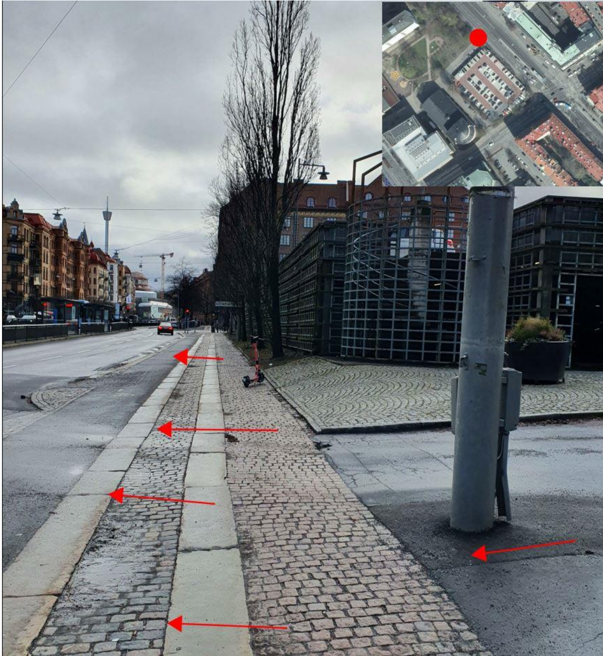
Figur 23. Bild tagen i samband med platsbesök. Röda pilar illustrerar rinnväg. Södra Vägen.
