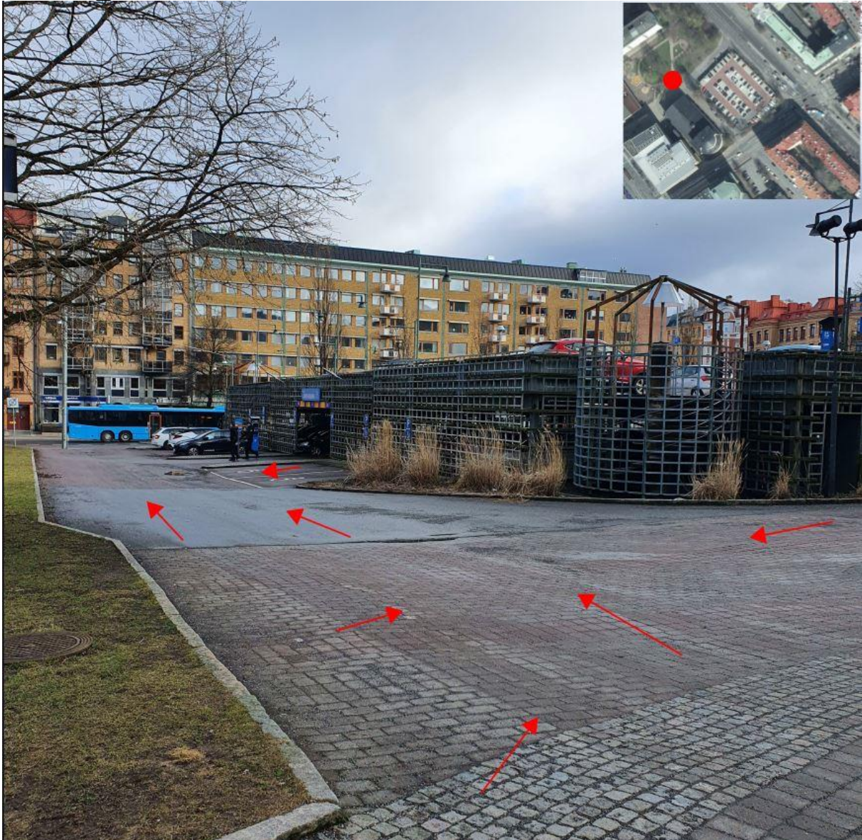
Figur 19. Bild tagen i samband med platsbesök. Röda pilar illustrerar rinnvägg. Karl Gerhards Plats.
